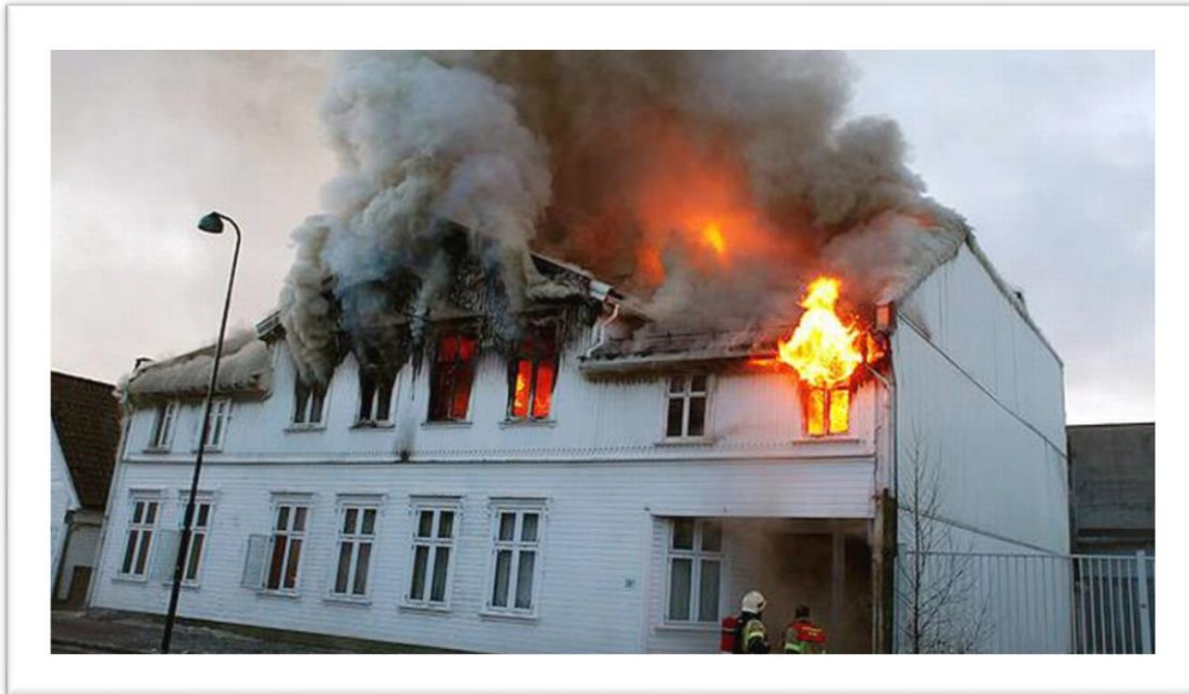
Figur 2 Brann i Tordenskjoldsgate i Kristiansand (Fædrelandsvennen 2011)
