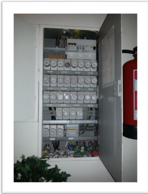
Figur 7 Haugen av sikringer i bunnen av skapet forteller at det er et høyt forbruk av dem i dette huset
